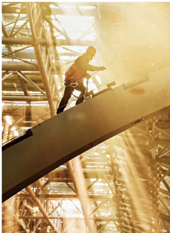
寒冷冬日里，北京城建集团工人在北京新机场主航站楼顶部建设施工 雷声/摄
