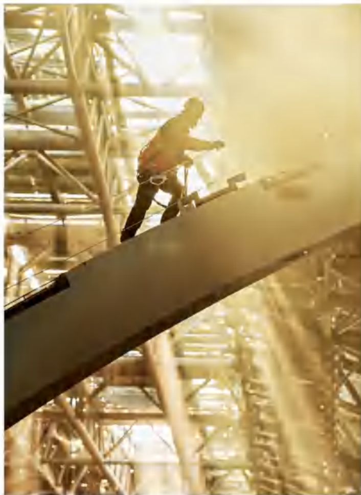
寒冷冬日里，北京城建集团工人在北京新机场主航站楼顶部建设施工 董声/摄
